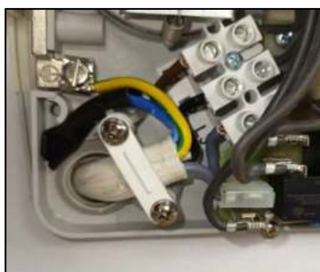
Příklad zapojení 3 x 400 V
