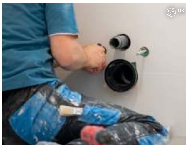
Obrázek 43: Příprava instalace keramiky
