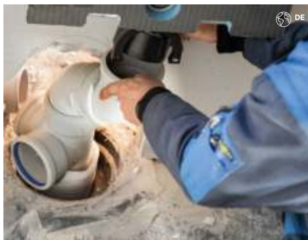
Obrázek 42: Sestava rozvodu odpadů v podlahové desce
