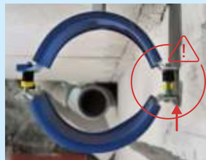
Obrázek 40: Správné srovnání trubkových objímek
