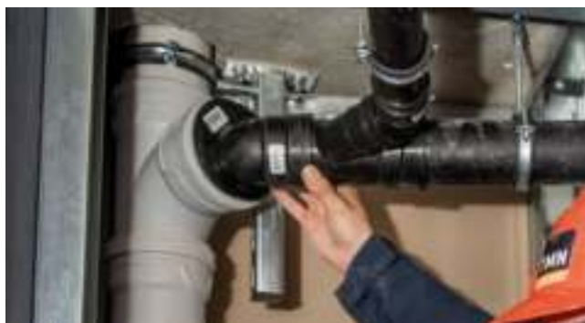
Obrázek 14: Příklad zakrytí potrubí
