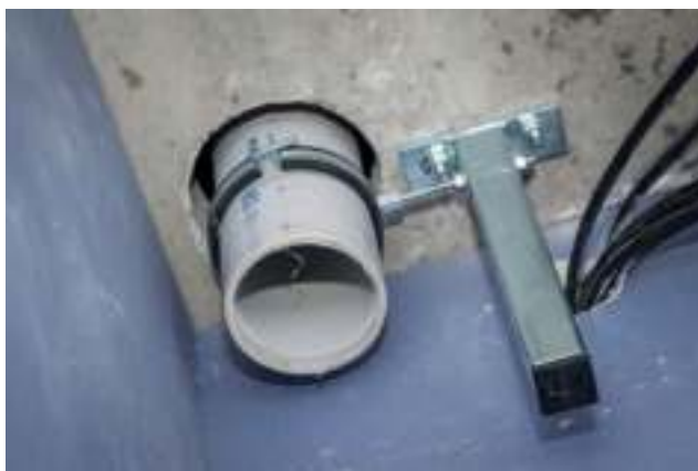
Obrázek 11: Upevnění na masivní prvky
